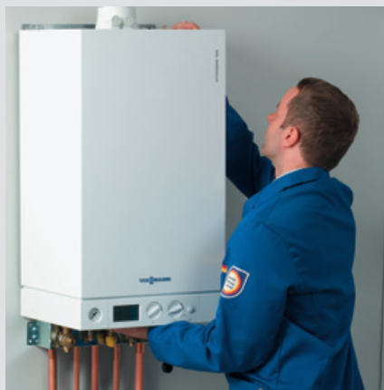
2 Montage de la chaudière
