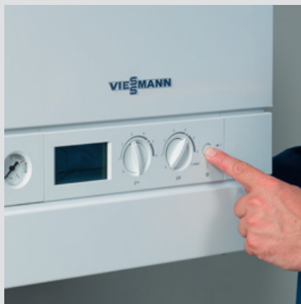
4 Mise en service
